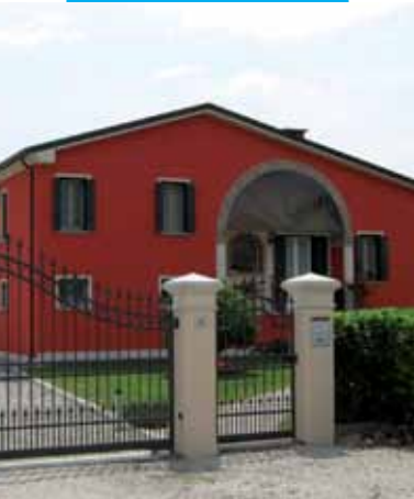
Фасад здания покрытый Silancolor Tonachino Plus
